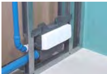
Aplicação em calha técnica
