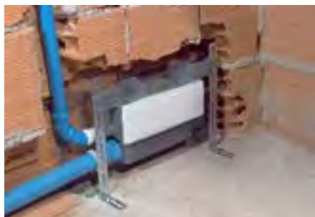
Aplicação em parede de alvenaria
